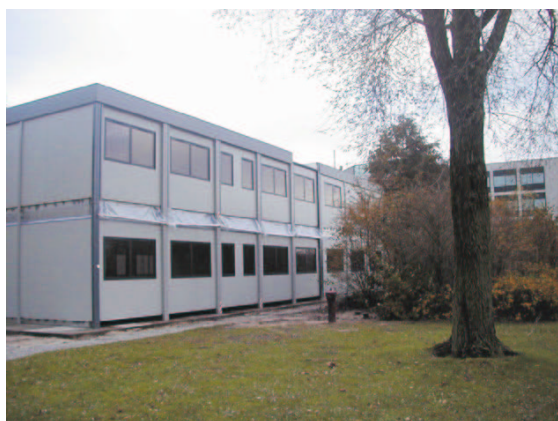
Figuur 4. In januari werd de uitbreiding van het CWI in gebruik genomen. De nieuwe bijgebouwen bieden plaats aan 55 onderzoekers
